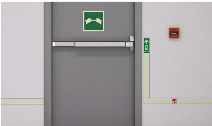
Puerta de salida de emergencia enmarcada con un cerco de 5cm de ancho como mínimo y señalizada con las correspondientes señales.
