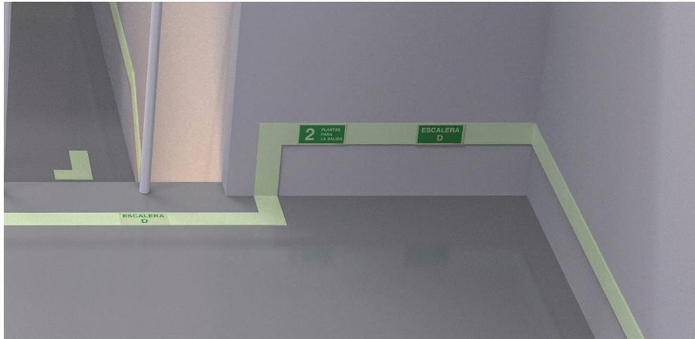
**D** - Señalización con la identificación del número de plantas a recorrer hasta la salida, instalada a baja altura e intercalada en la banda fotoluminiscente del balizamiento de la pared - Sinalux®-LLL
